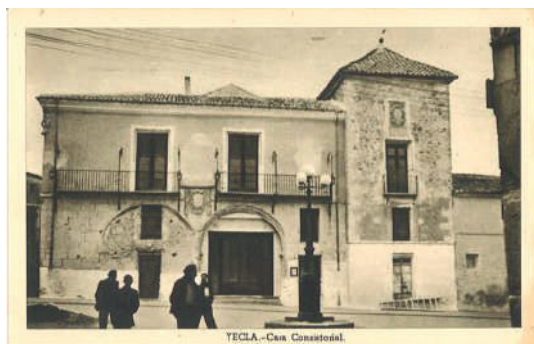
FIG. 2 - Yecla: I Casa-Ayuntamiento y torre aneja con los arcos del pórtico y la ventana de ángulo tabicados. Primer tercio del siglo XVI. (Foto: Estanislao Ripoll Pérez, de hacia 1930 -Huecograbado Fournier, Vitoria).
